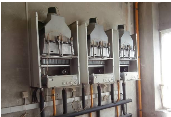
Obr. 2: Plynová kotelna staré budovy
